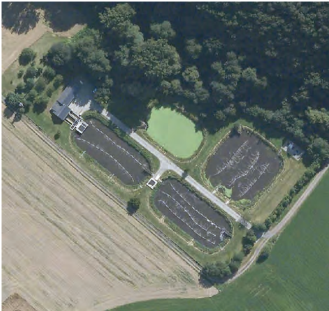
Abb. 1: Die Kläranlage Karbachtal
