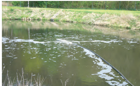
Abb. 4: Der Nachklärteich mit einem Pendelbelüfter
